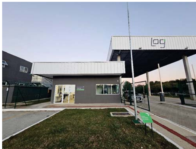
Vista geral da entrada do imóvel
