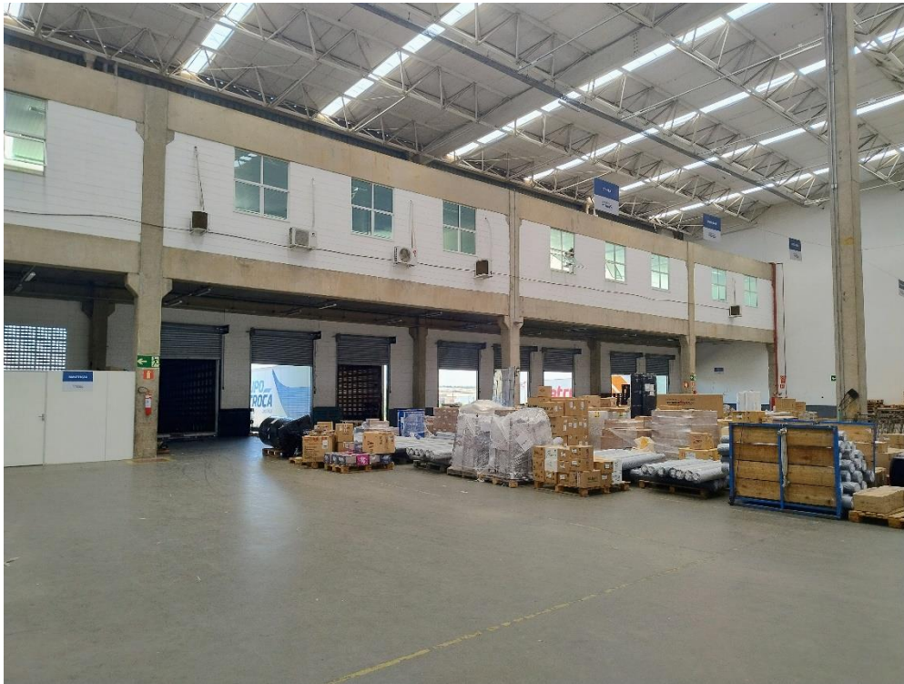
Vista geral do imóvel
