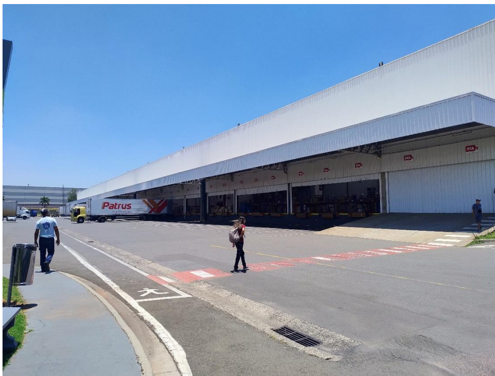
Vista geral do imóvel
