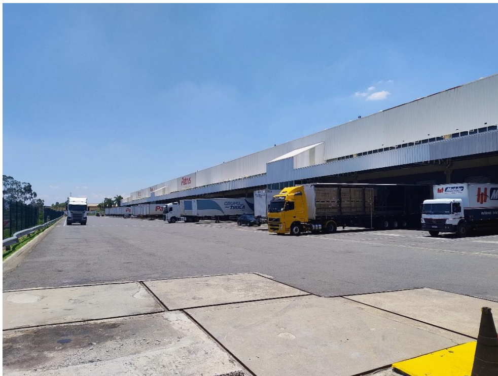
Vista geral do imóvel
