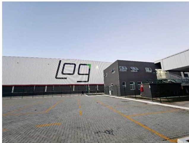
Vista geral do imóvel
