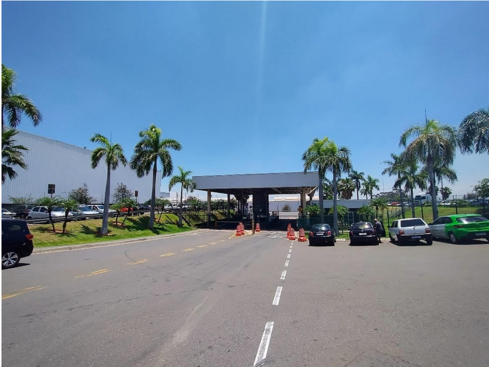
Frente do imóvel para Rua Pérola
