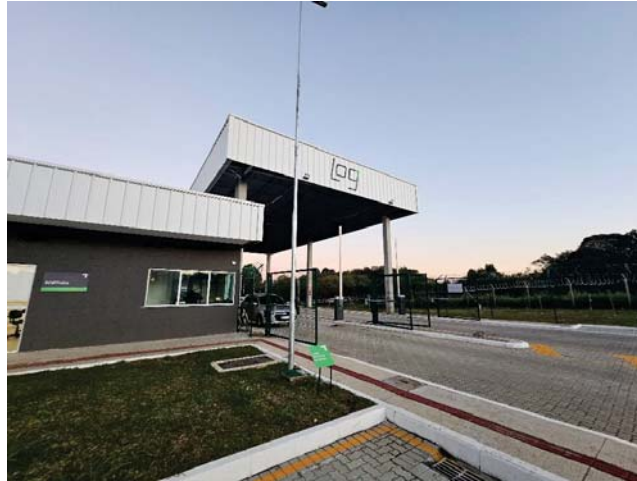
Vista geral da entrada do imóvel
